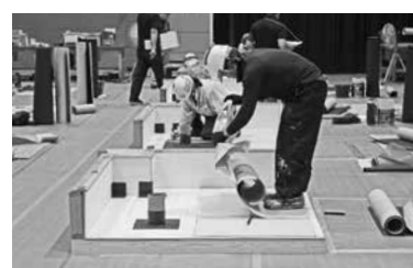
改質アスファルトシート常温粘着工法の実技試験会場
