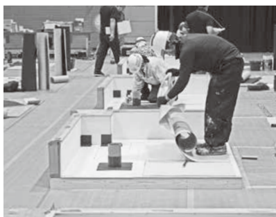
前々回の改質アスファルトシート常温粘着 工法の実技試験会場
