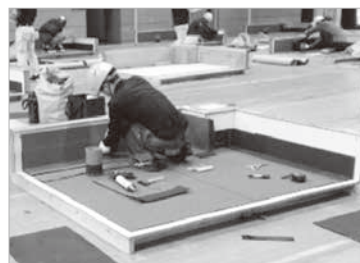
改質アスファルトシート常温粘着工法の実技試験のようす
