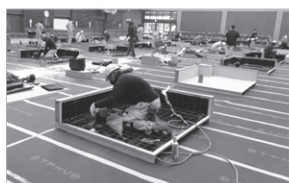
改質アスファルトシート常温粘着工法の試験の様子
