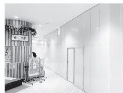
■店舗の改修工事
