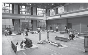
前回の改質アスファルトシート常温粘着工法の試験のようす
