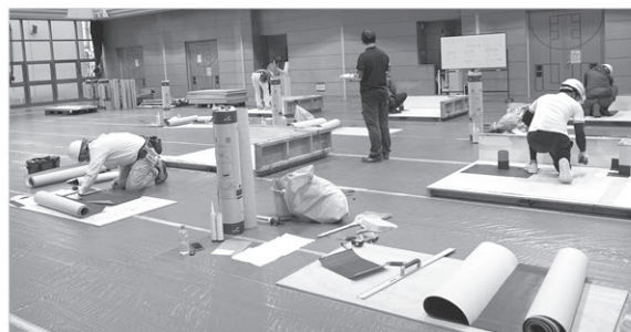
改質アスファルトシート常温粘着工法防水の実技試験のようす
